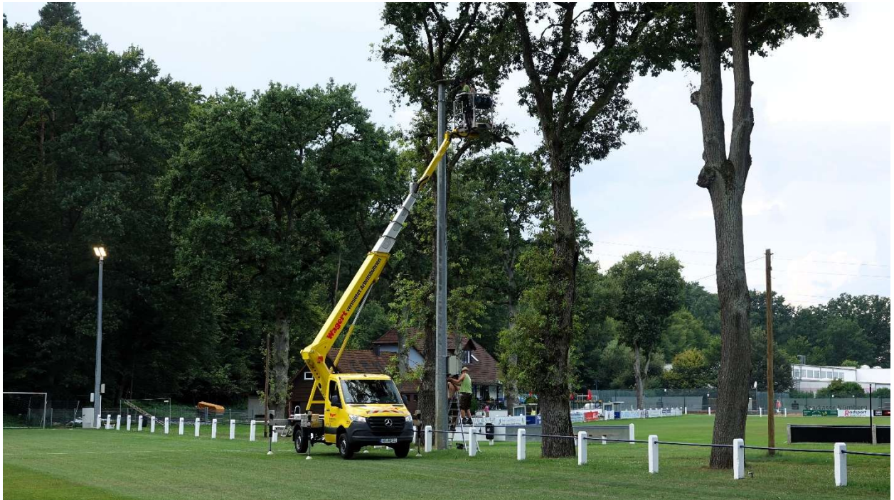
Abb. 3: Einsatz eines Hubwagens zu Montage der LED-Strahler
