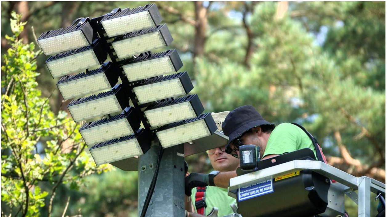
Abb. 2: Montage der neuen LED-Strahler
